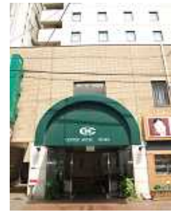
センターホテル大阪 外観
